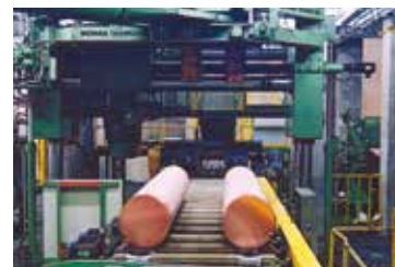
Vertikale kontinuierliche Stranggießanlage für Pressbolzen
