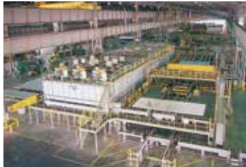
Durchlaufhomogenisierungsanlage mit Transporteinrichtung
