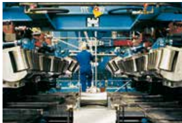
Montage einer 24" Linealeinformstrecke
